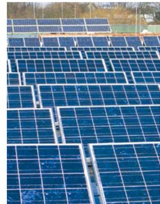
Sonnenkollektoren auf dem Dach der Gewerbeschule G17. Der Schulverein speist jährlich rund 18000 Kilowattstunden Strom aus erneuerbaren Energien ins Stromnetz ein. Das entspricht dem jährlichen Strombedarf von fünf Vier-Personen-Haushalten. Foto: Wolfgang Sander
