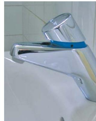
In allen Toiletten des Albrecht-Thaer-Gymnasiums wurden neue Wasserhähne mit automatischem Stopp und Wasserspartasten in den Spülkästen eingebaut.
